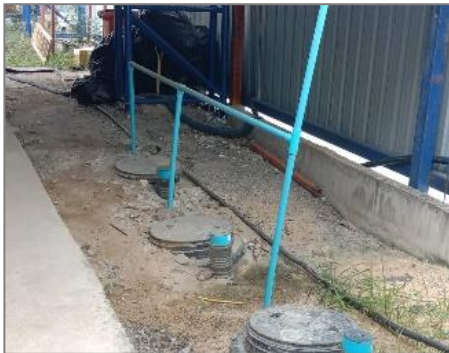
ภาพที่ 2.2-19 ถังบำบัดน้ำเสียสำเร็จรูป
