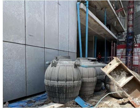
ภาพที่ 2.2-19 ถังบำบัดน้ำเสียสำเร็จรูป
